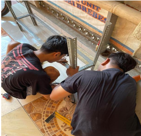
Dokumen pemasangan rangka
