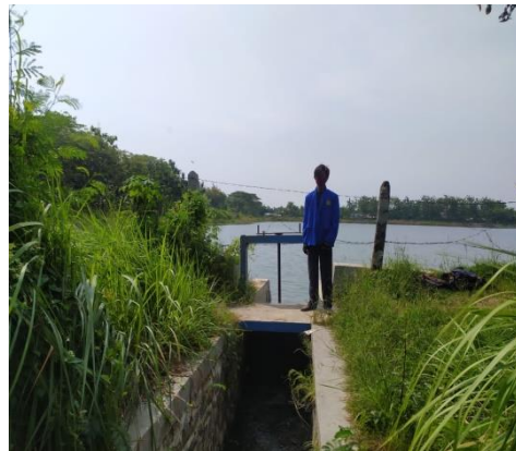
Pintu air keluar embung desa kersana
