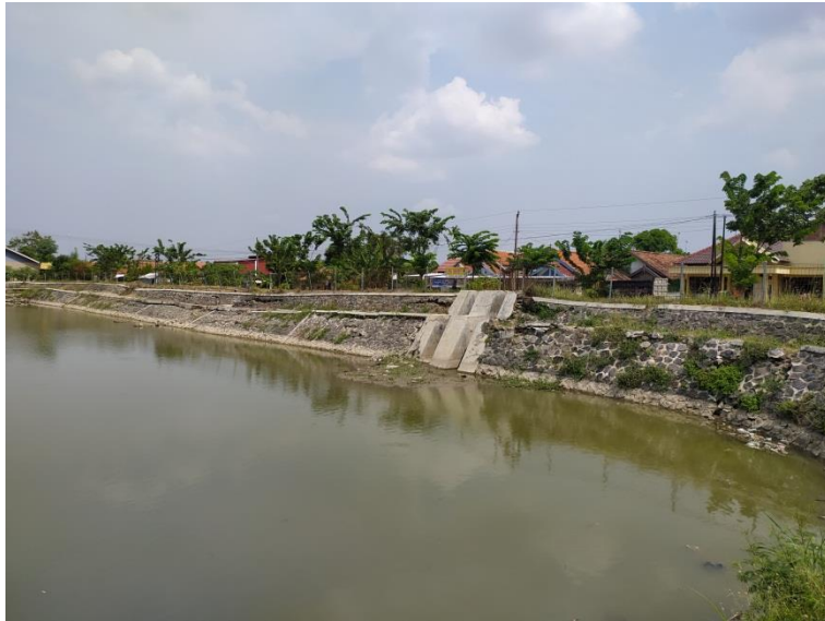
Gambar 3. 5 Kondisi Air Di Embung Lebih Rendah Dari Jalur Irigasi
