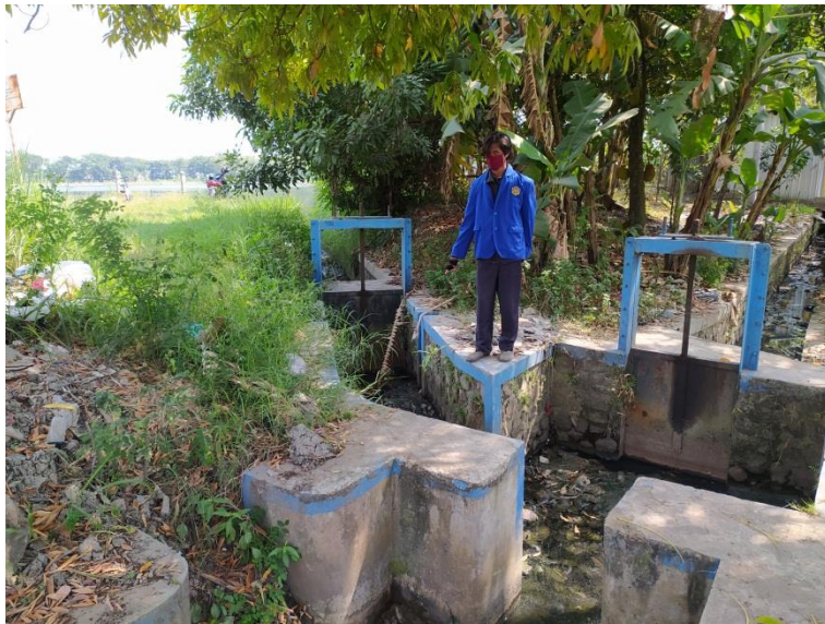
Gambar 3. 4 Jalur Keluar Masuk Air Di Embung Desa Kersana
