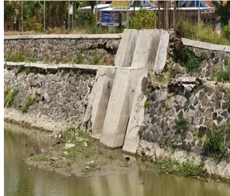
Kondisi air embung di desa jagalempeni
